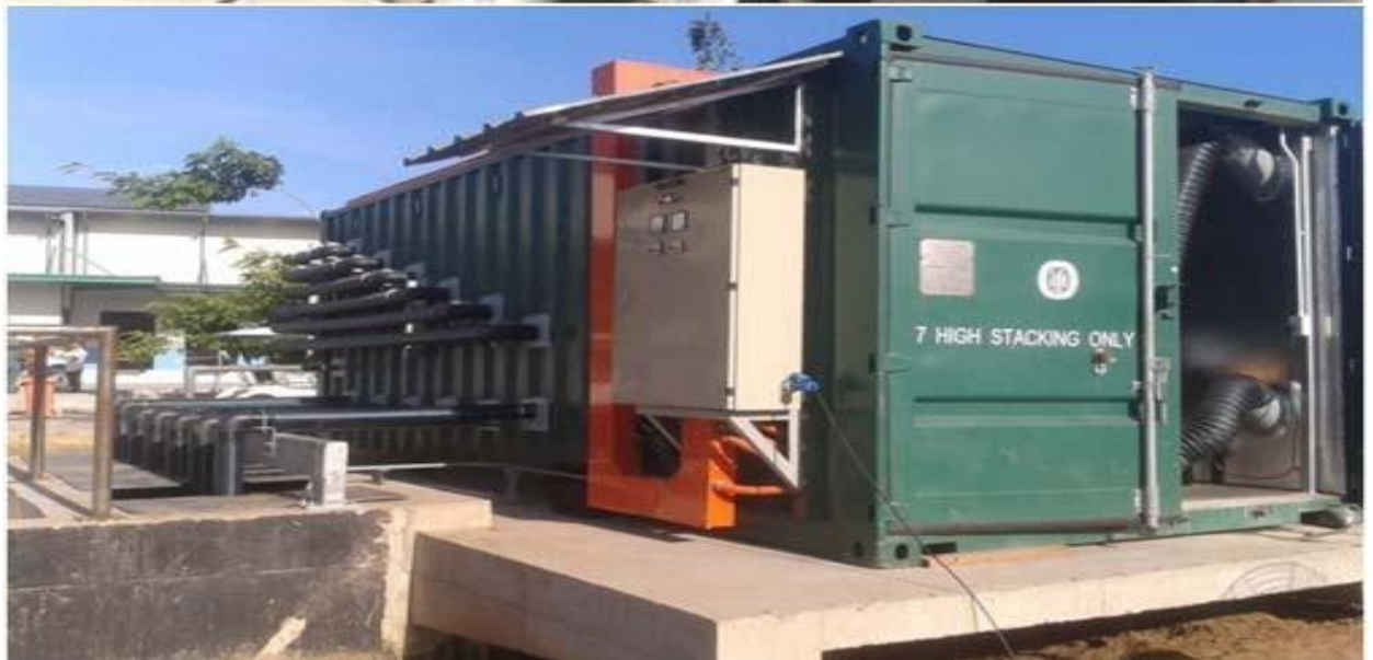
THI CÔNG HỆ THỐNG RỬA XE TẢI TỰ ĐỘNG TRUCK WASH SYSTEM AUTOMATICALLY
