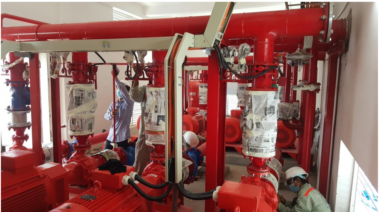
THI CÔNG HỆ THỐNG CƠ ĐIỆN TỔNG THỂ VÀ PCCC INSTALLATION THE GENERAL M/E & FIRE FIGHTING SYSTEM
