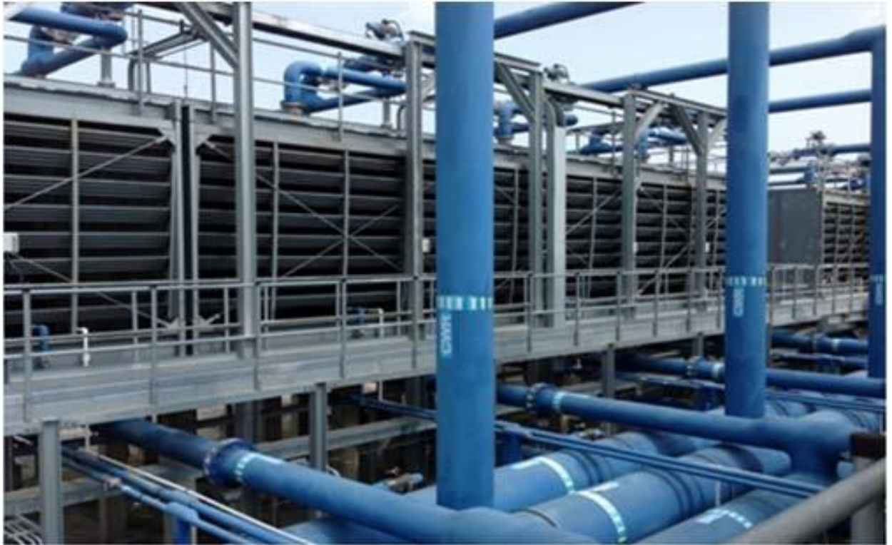
LẮP ĐẶT, BẢO TRÌ HỆ THỐNG LẠNH AIR - CONDITION SYSTEM
