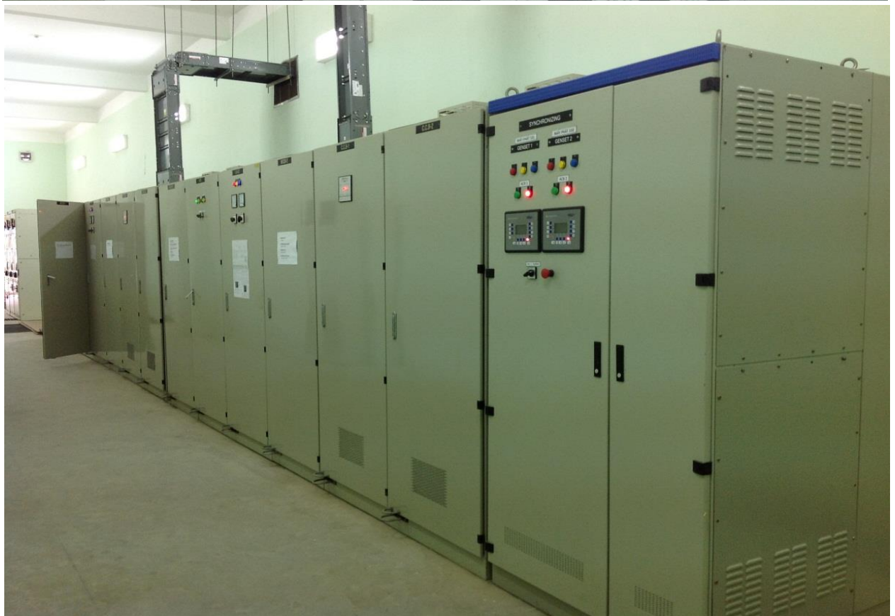
HẠ TRẠM 2000KVA VÀ ĐI DÂY ĐỘNG LỰC POWER STATION 2000KVA
