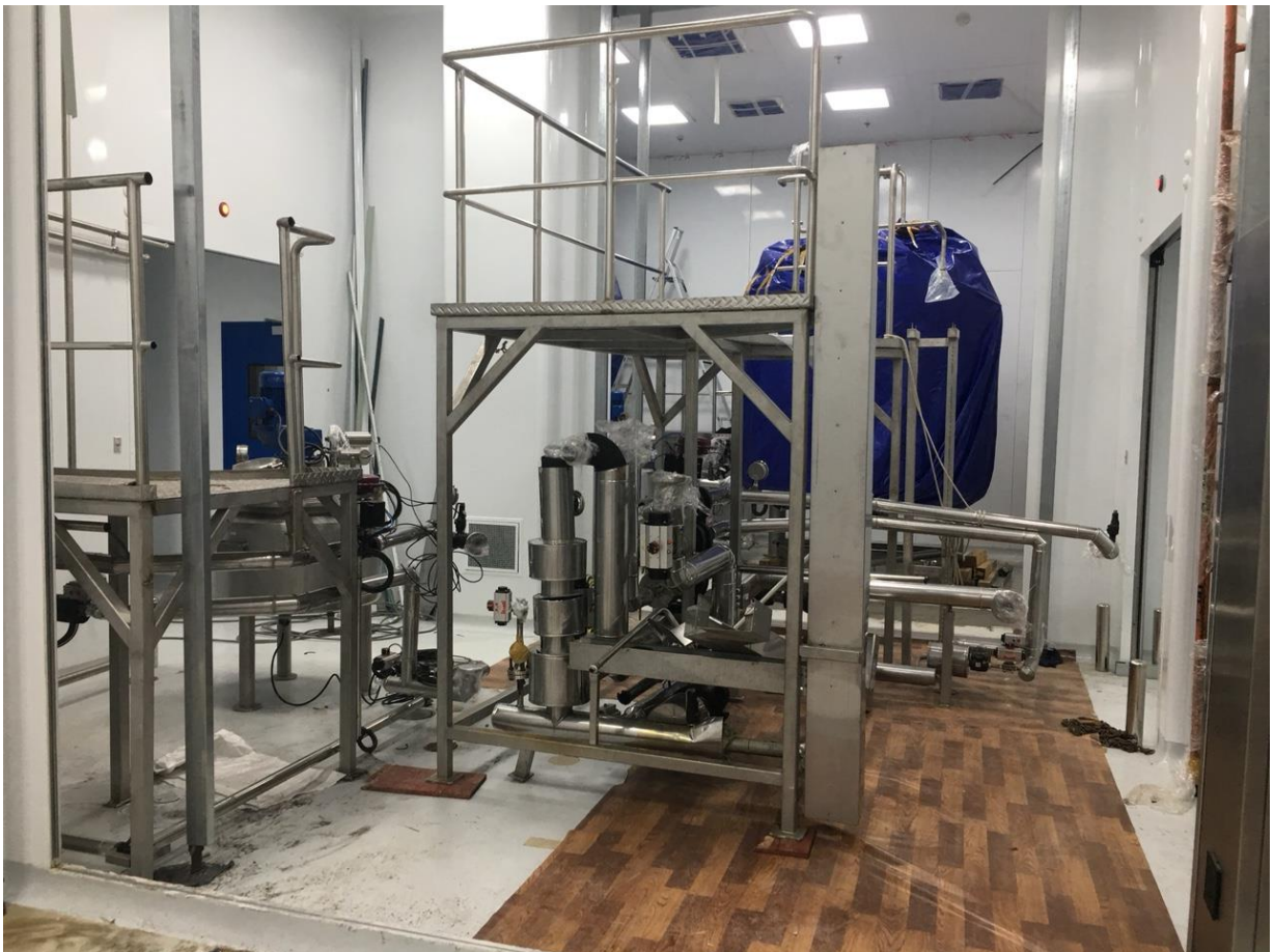
LẮP ĐẶT HỆ THỐNG BỒN KHUẤY TRỘN TRONG PHÒNG SẢN SUẤT THUỐC INSTALL THE MIXING TANK SYSTEM IN THE PRODUCTION OF MEDICINE
