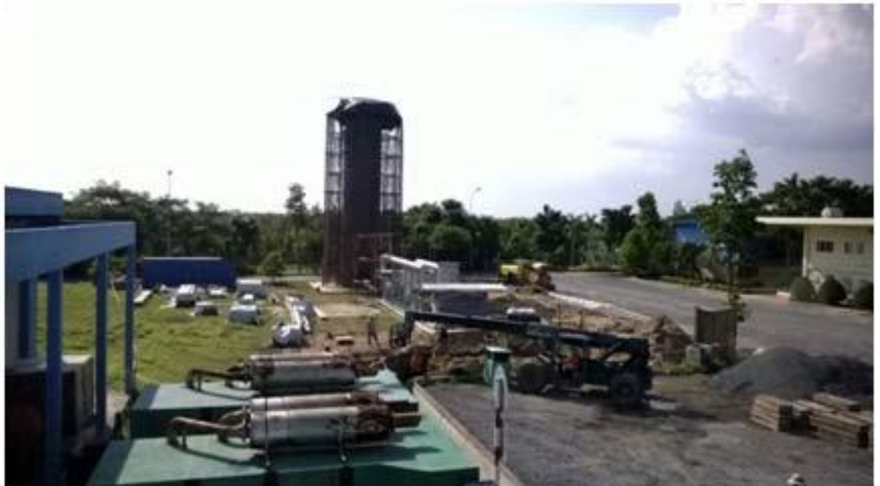
THI CÔNG HỆ THỐNG ĐIỆN VÀ ĐƯỜNG ỐNG CÔNG NGHỆ LFG TOWERS AND GAS HANDING SYSTEM LFG
