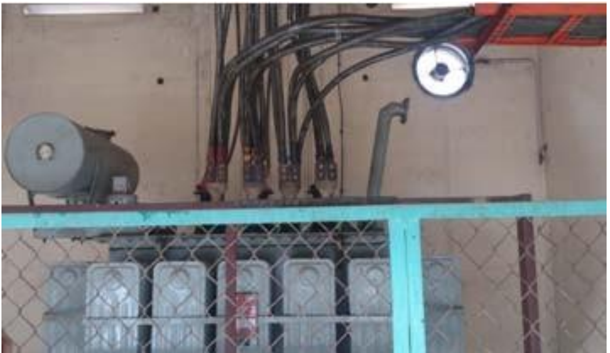
BẢO TRÌ TRẠM BIẾN ÁP 1500KVA MAINTENANCE 1500KVA TRANSFORMER
