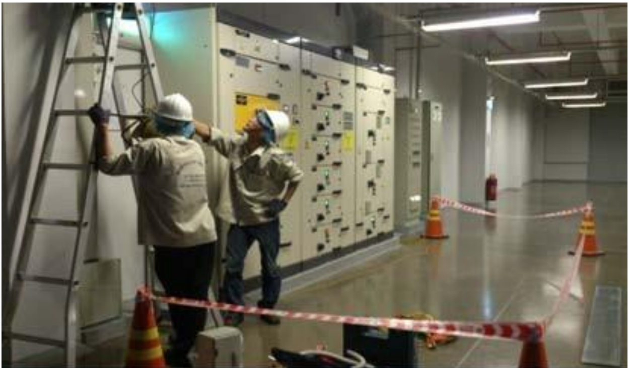
LẮP ĐẶT HỆ THỐNG ĐỘNG LỰC VÀ CHIẾU SÁNG POWER & LIGHTING SYSTEM
